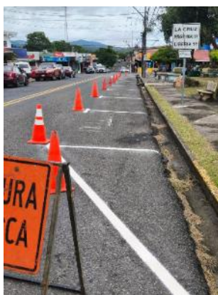
Figura N° 27. Demarcación de vías
