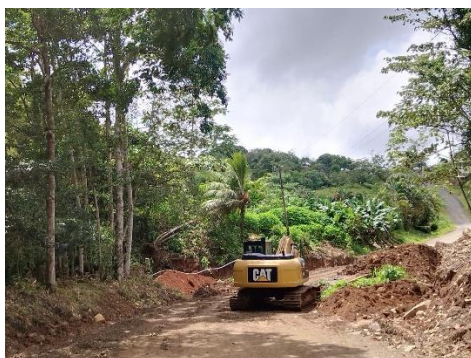
Figura N° 57. Rehabilitación de paso provisional Piedras Azules- Santa Cecilia
