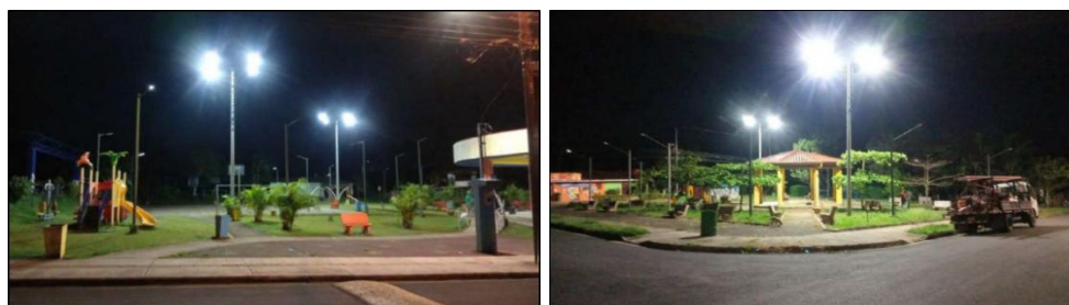
Figura N° 96. Iluminación parques Santa Cecilia y La Garita
