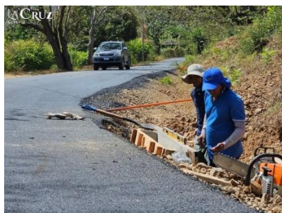
Figura N° 53. Construcción de cabezales en Bello Horizonte y muro de retención en El Jobo
