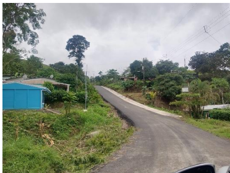
Figura N° 63. Mezcla asfáltica en Piedras Azules- Santa Cecilia
