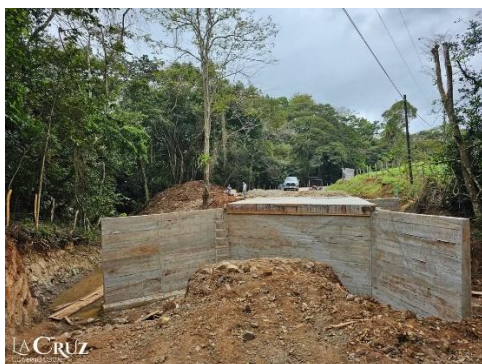
Figura N° 62. Construcción de alcantarilla de cuadro Los Manzanos- La Garita
