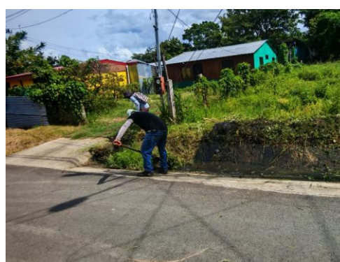
Figura N° 51. Limpieza de vías (chapia, descuaje, cunetas)
