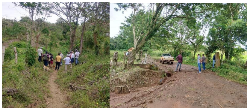
Figura N° 48. Inspecciones para apertura de caminos nuevos en Santa Cecilia
