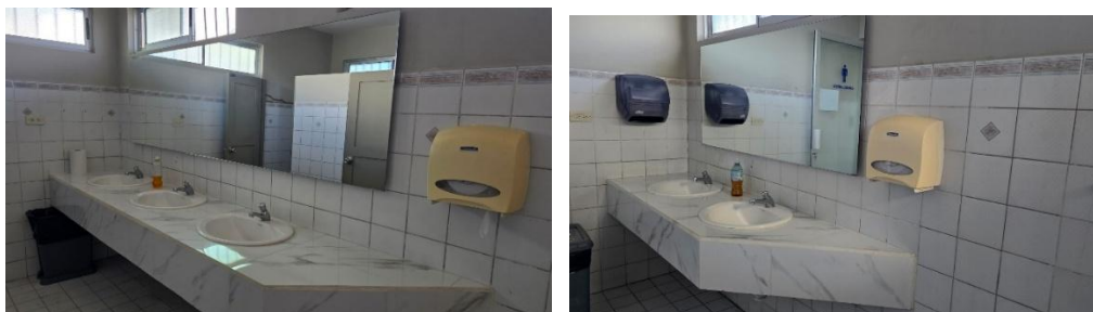
Figura N° 117. Mejoras en los servicios sanitarios de las oficinas municipales
