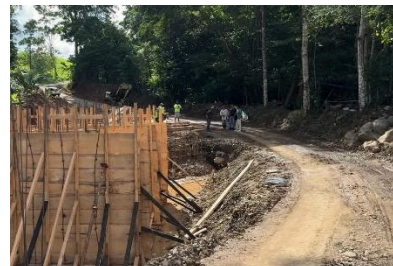
Figura N° 65. Construcción de alcantarilla de cuadro camino Belice –Piedras Azules
