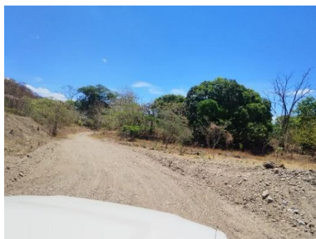
Figura N° 56. Rehabilitación del camino Aguas Calientes
