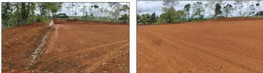
Figura N° 95. Nivelación plaza de futbol San Rafael
