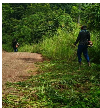
Figura N° 51. Limpieza de vías (chapia, descuaje, cunetas)
