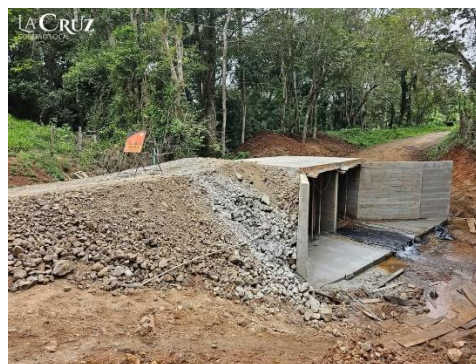
Figura N° 62. Construcción de alcantarilla de cuadro Los Manzanos- La Garita
