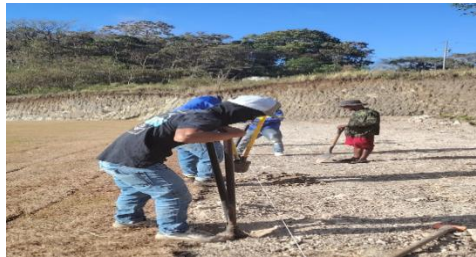
Figura N° 4. Grupo de personas trabajando en la instalación de la malla
