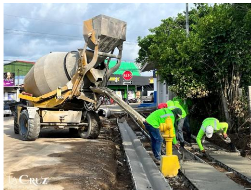
Figura N° 64. Instalación de tubería y construcción de acera La Cruz
