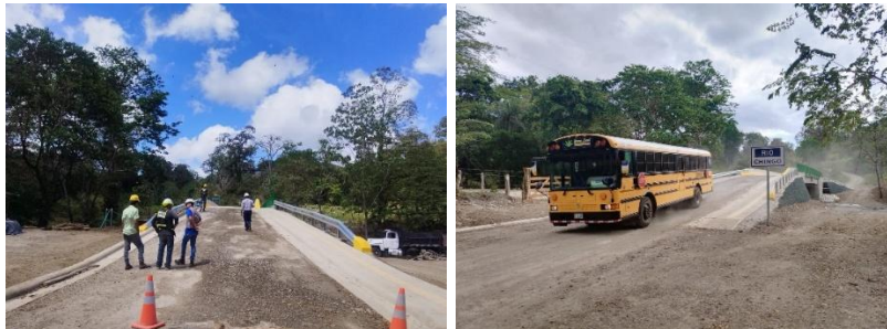
Figura N° 47. Inspecciones en Proyecto Construcción de Puente Rio Chingo-Santa
