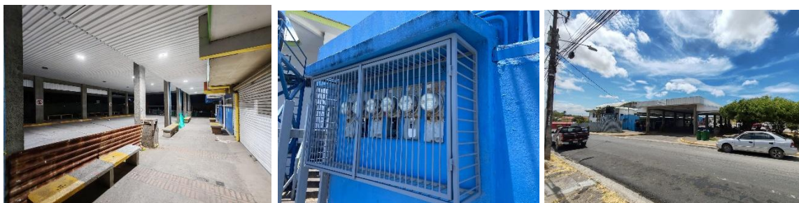
Figura N° 119. Mejoras en la terminal de buses y obras complementarias
