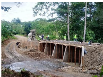
Figura N° 65. Construcción de alcantarilla de cuadro camino Belice –Piedras Azules
