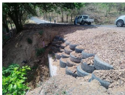
Figura N° 53. Construcción de cabezales en Bello Horizonte y muro de retención en El Jobo
