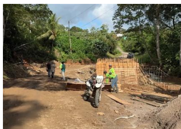
Figura N° 65. Construcción de alcantarilla de cuadro camino Belice –Piedras Azules
